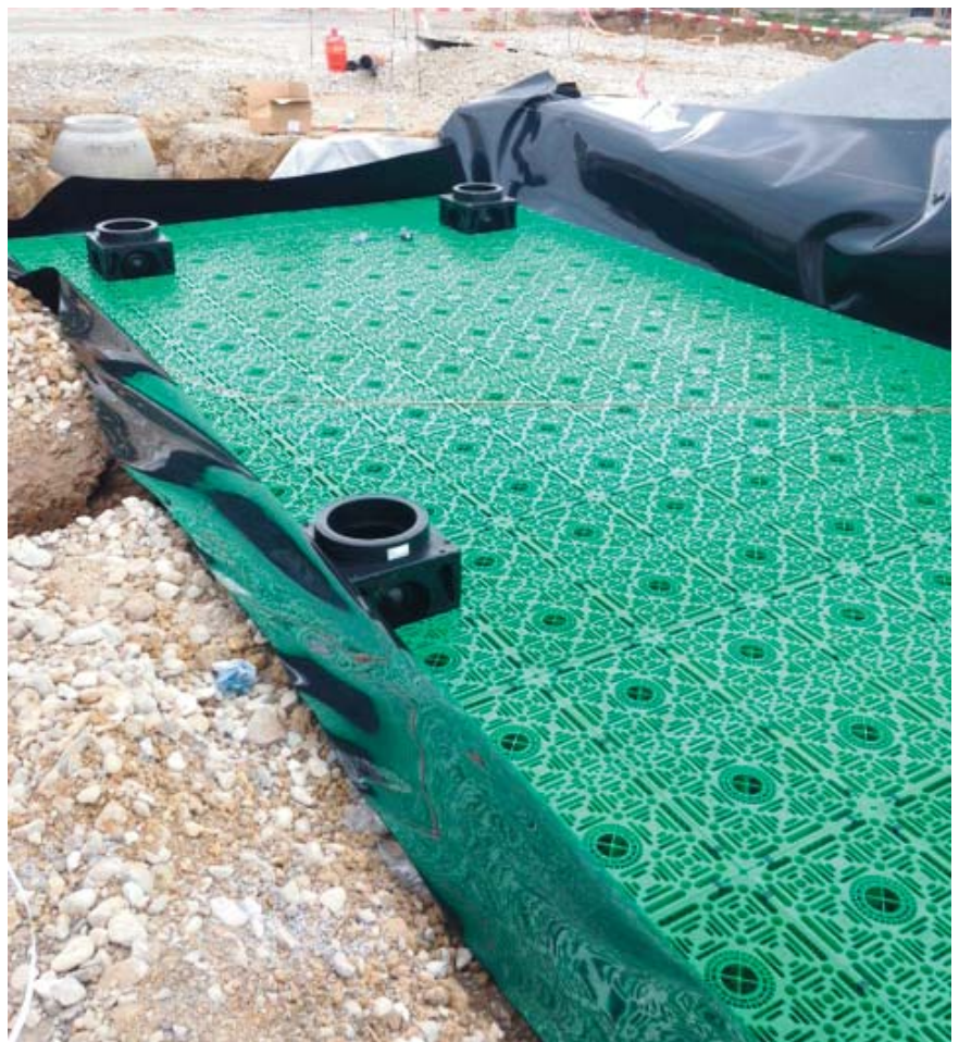
Für den Einsatz als Retentionskörper wird der gesamte Block dicht in PE-Folie eingeschweißt.
