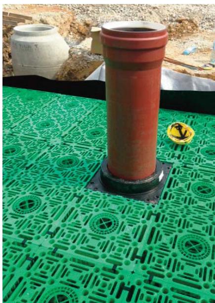
Der Systemschacht aus PP kann an jeder beliebigen Position in das System integriert werden und mit einem Steigrohr (in diesem Fall in DN/OD 400) nach oben hin verlängert werden.
