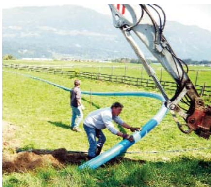
Vorbereitung für das Einschieben des Rohrstanges in die alte Wasserleitung
