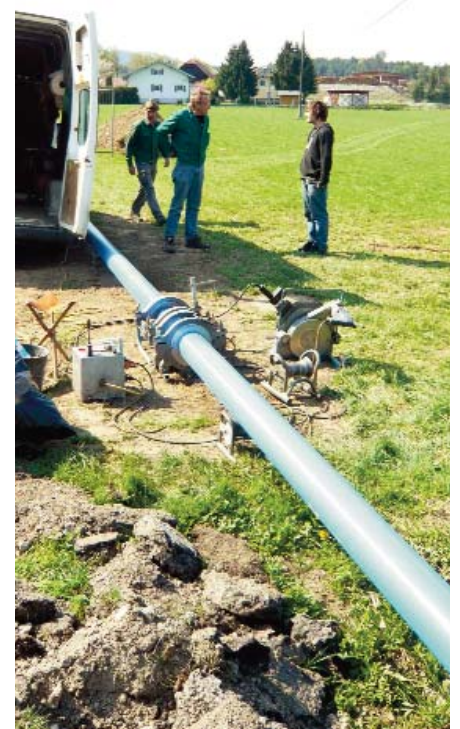
Schweißen der 12 Meter langen AQUALINE RC ROBUST-Rohre zu einem Rohrstrang
