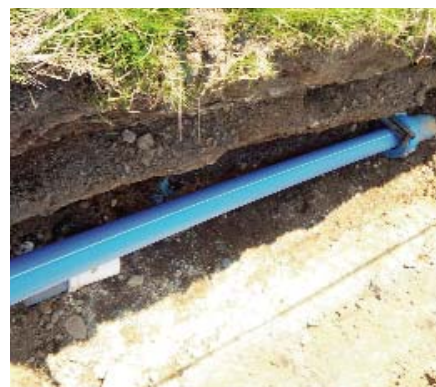
AQUALINE RC ROBUST nach der Verlegung
