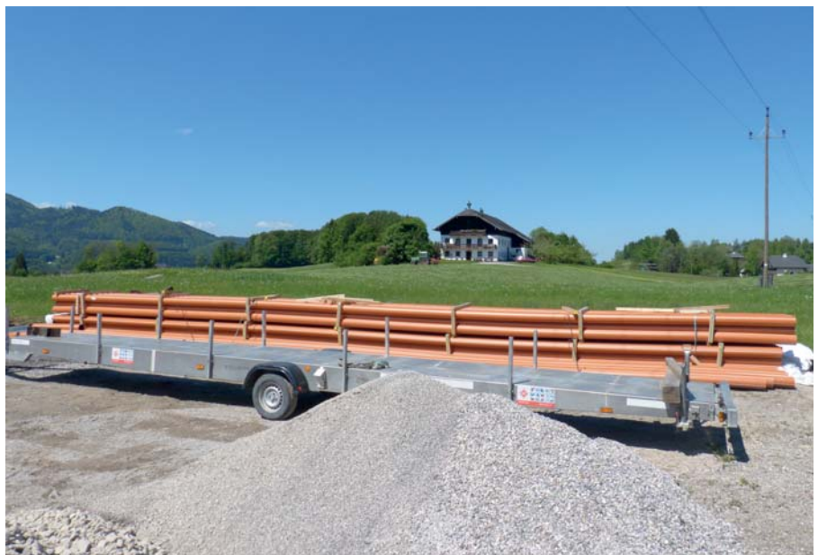
Die 16 Meter langen Stangen wurden mit Elektroschweißmuffen der Marke +GF+ verbunden. Auch die E-Muffen wurden von Pipelife Austria geliefert.
