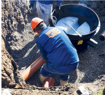
Bei der Wahl des Schachtsystems entschied sich der Auftraggeber für die bewährten und langfristig dichten Romold-Schächte aus Polyethylen.
