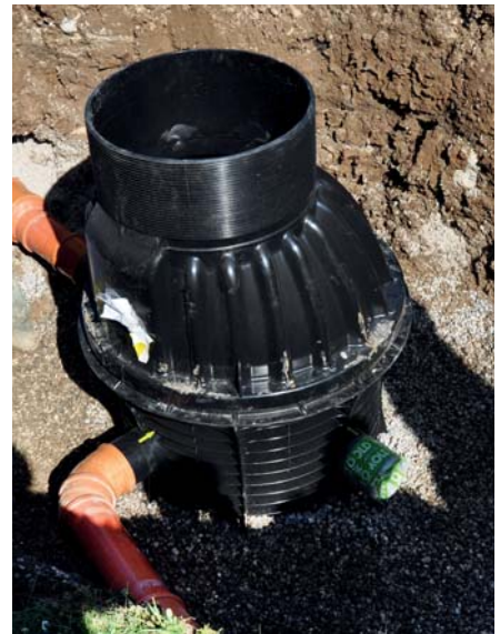
Bei der Wahl des Schachtsystems entschied sich der Auftraggeber für die bewährten und langfristig dichten Romold-Schächte aus Polyethylen.
